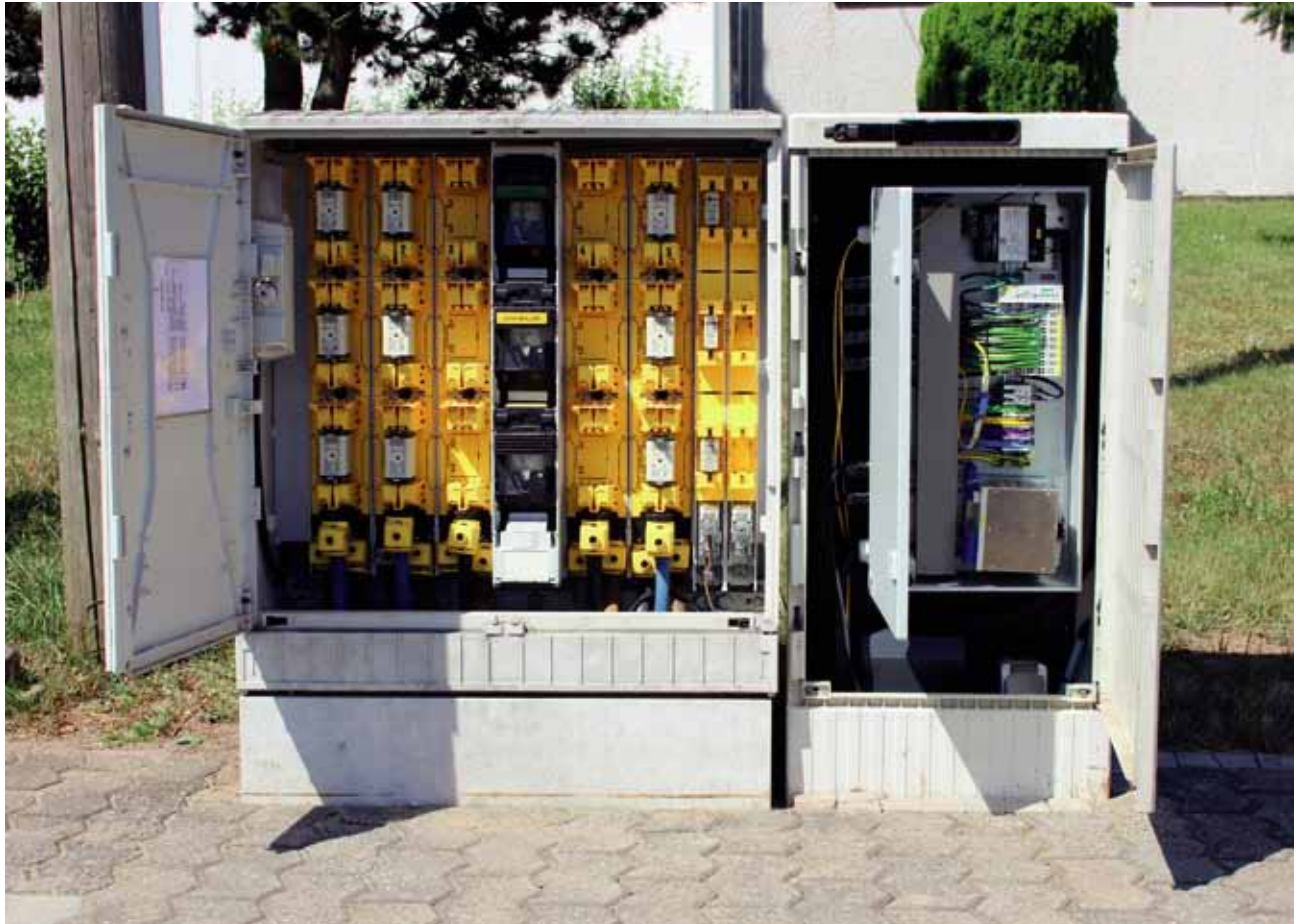
Bild 3. Die Trennstellen im linken Kabelverteilerschrank werden durch Messsensorik im ergänzten rechten Verteilerschrank verarbeitet und über GPRS und Glasfaser übertragen.
